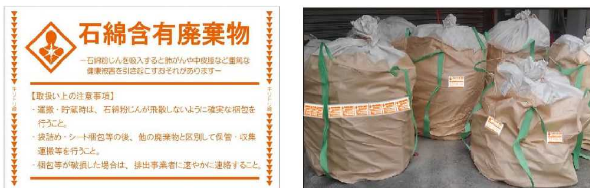
図3-7 石綿含有産業廃棄物の表示テープ
