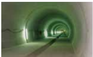
千田雨水1号幹線 (平成14年)
