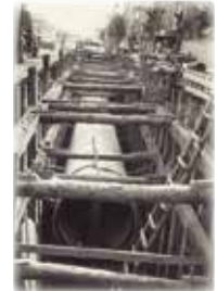
江波幹線下水道布設工事
