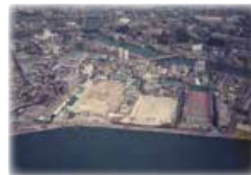
完成後の大州下水処理場
