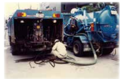
高圧洗浄車による下水管清掃作業
