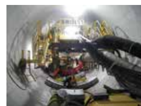
雨水きよ建設工事
