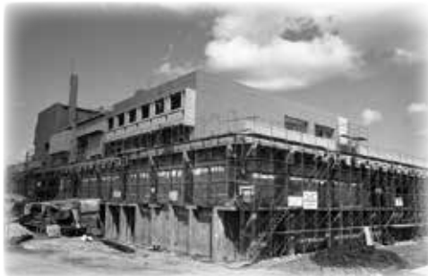
広島市公文書館所蔵 旭町下水処理場築造工事
