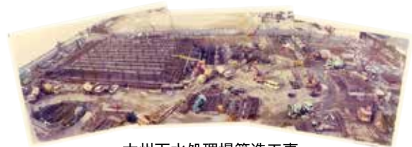
大州下水処理場築造工事
