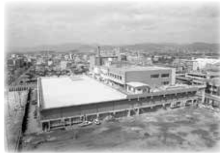
広島市公文書館所蔵 増設工事後の旭町下水処理場
