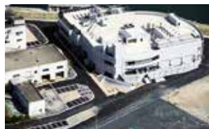
新千田ポンプ場 (平成21年)
