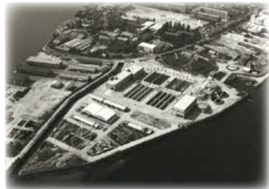
千田下水処理場高級処理施設
