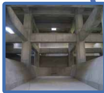
江波雨水滞水池
