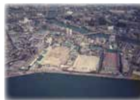
完成後の大州下水処理場
