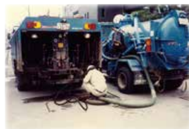
高圧洗浄車による下水管清掃作業
