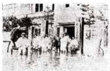
幟町小学校通りの浸水状況(大正15.9.11)
