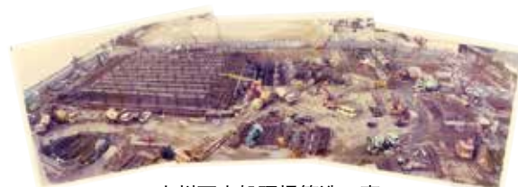
大州下水処理場築造工事
