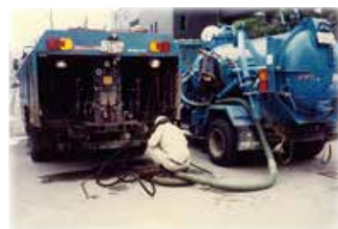
高圧洗浄車による下水管清掃作業
