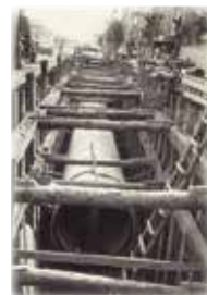
江波幹線下水道布設工事
