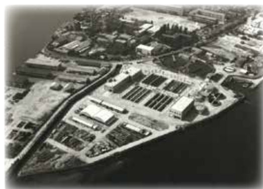
千田下水処理場高級処理施設
