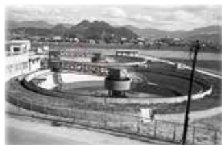
広島市公文書館所蔵 千田下水処理場最初沈殿池
