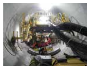
雨水きよ建設工事
