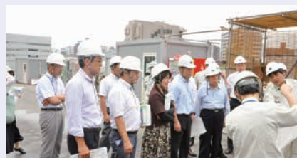
広島高速5号線工事現場(二葉の里)視察(8/3)
