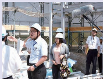
建設委員会 (7/22) JR可部線電化延伸事業工事現場
