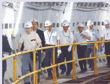
消防上下水道委員会 (7/25) 宇品地区下水道築造25-20号工事現場
