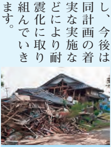
熊本地震被害状況(益城町)
