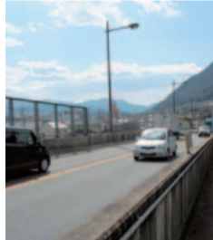
可部バイパス(可部跨線橋)
