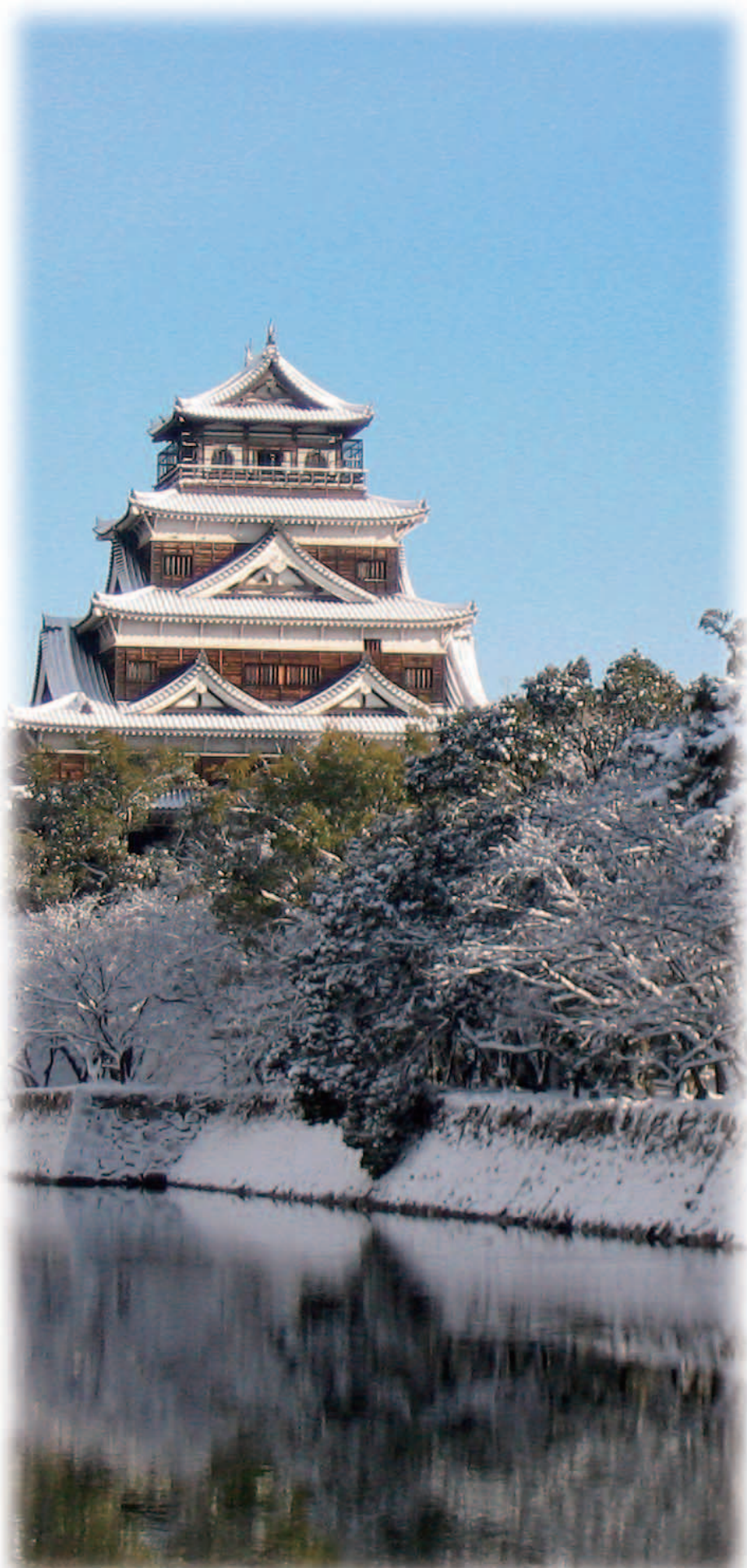
広島城 (中区) (写真提供:広島城)
