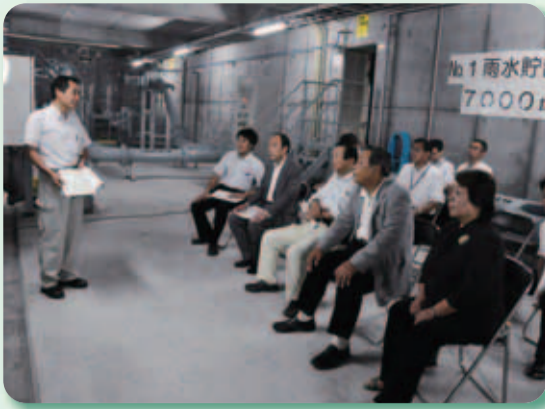
市内視察(8月9日、大州雨水貯留池)
