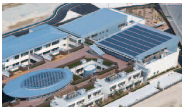
広島特別支援学校に設置された太陽光パネル
