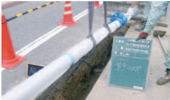
水道管の更新
