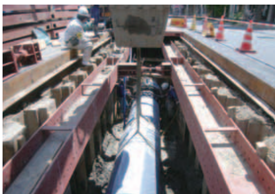
水道管の更新
