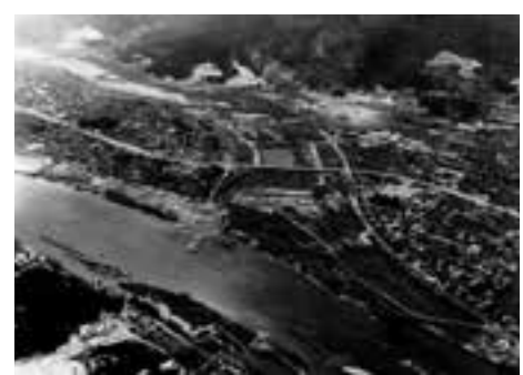
工事中の放水路(昭和37年) 所蔵:太田川河川事務所
