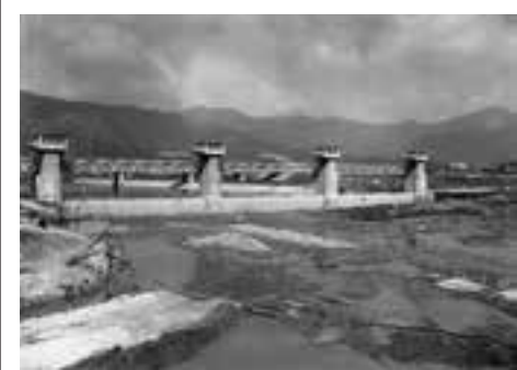
工事中の祇園水門(昭和38年) 所蔵:市公文書館
