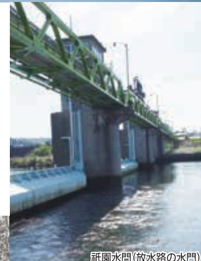
祇園水門(放水路の水門)
