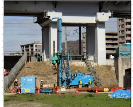
横断歩道橋の基礎工事の様子(3月14日)
