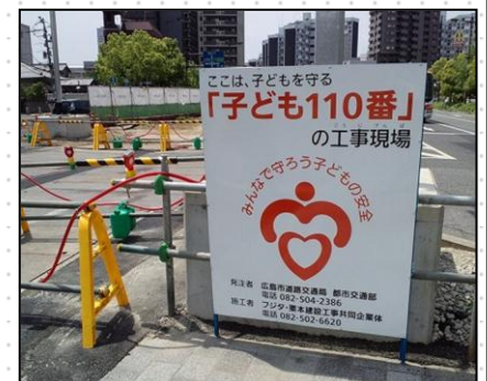
工事現場に設置している
