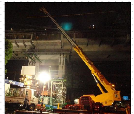
桁設置の夜間工事の状況（7月上旬）
