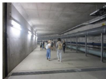
大州雨水貯留池の見学の様子
