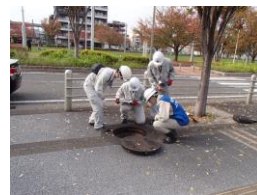
管路調査状況
