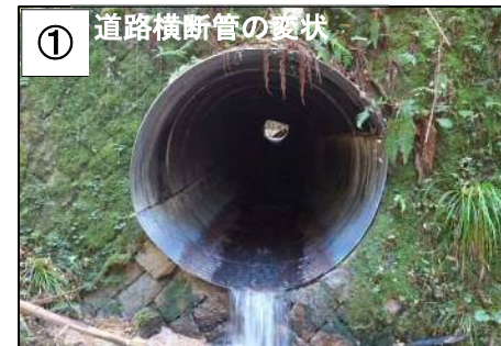
〔安佐南区施工〕
