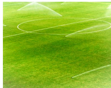
芝の散水設備
